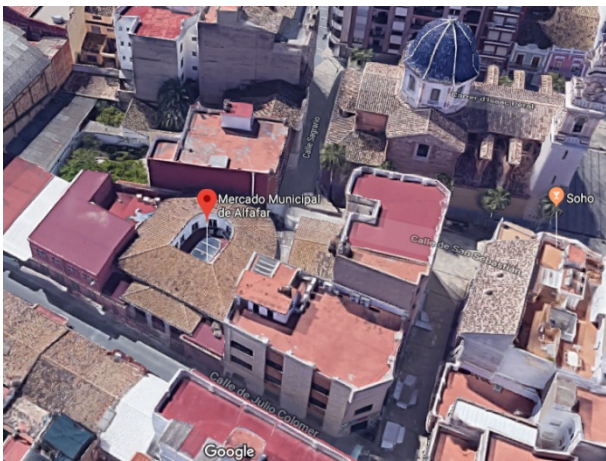
3. Entorno (fachada norte)
