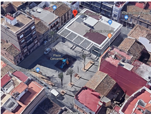
3. Entorno (fachada norte)
