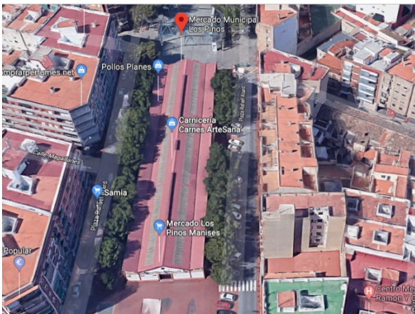
3. Entorno (fachada sur)
