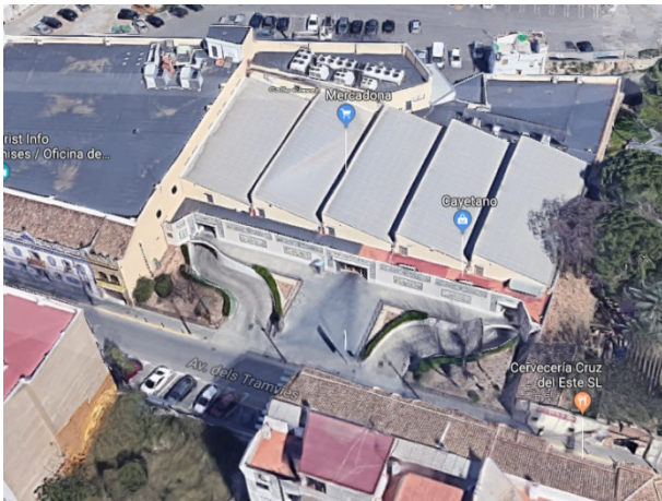
3. Entorno (fachada oeste)
